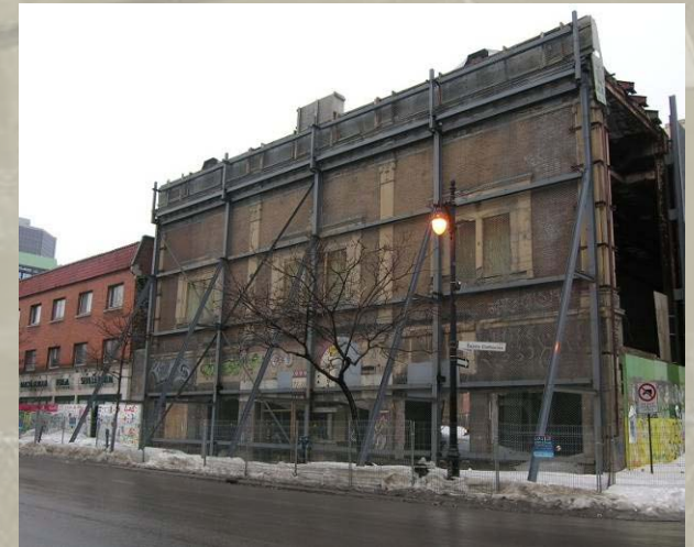
Pendant la démolition
