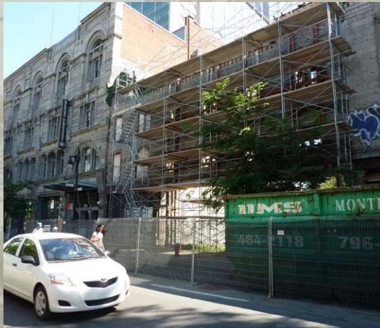
Pendant la démolition
