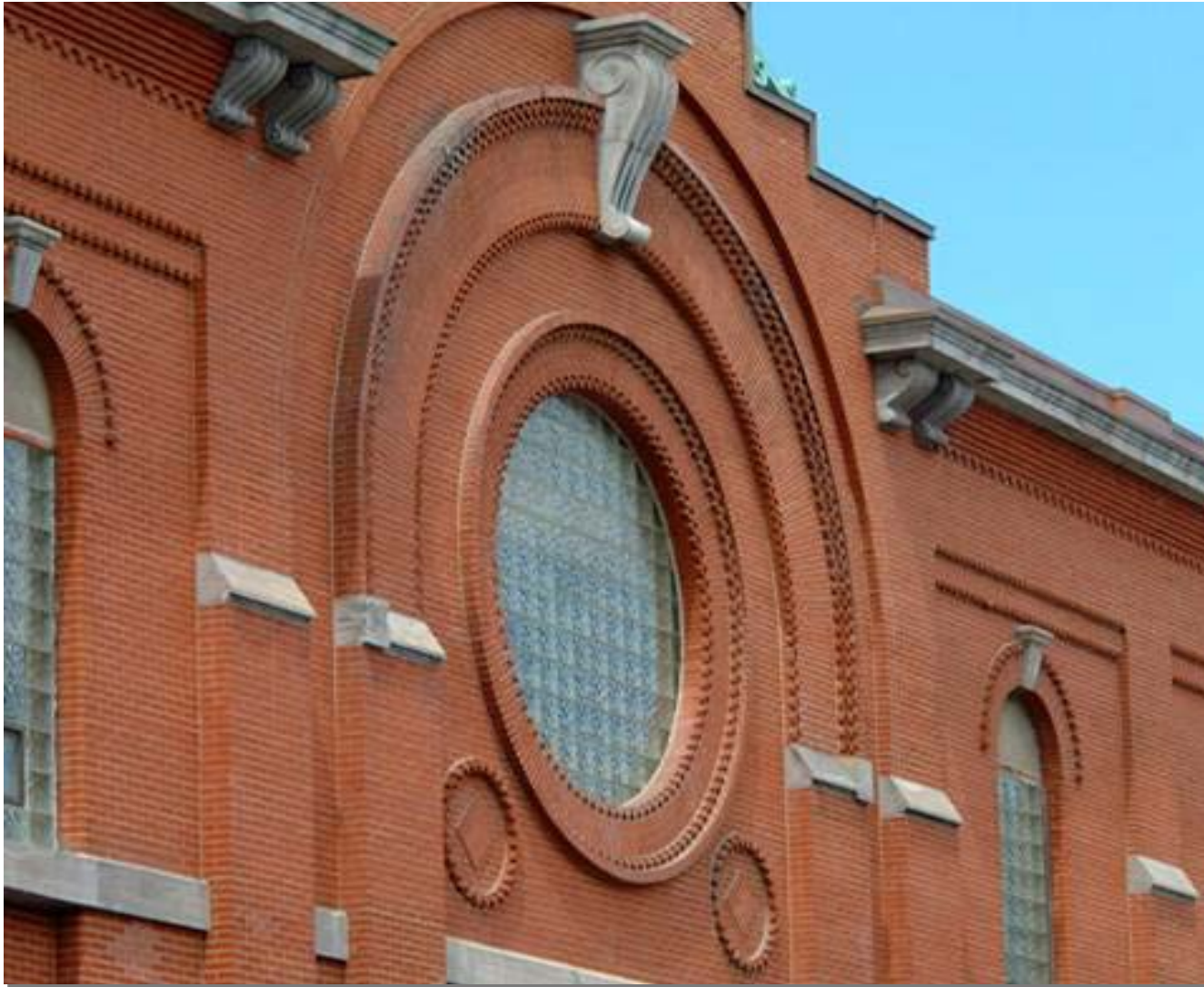
Poste de transformation Adélarde-Godbout, mis en service en 1901.
