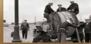
Construction du réseau de distribution souterrain vers 1960
