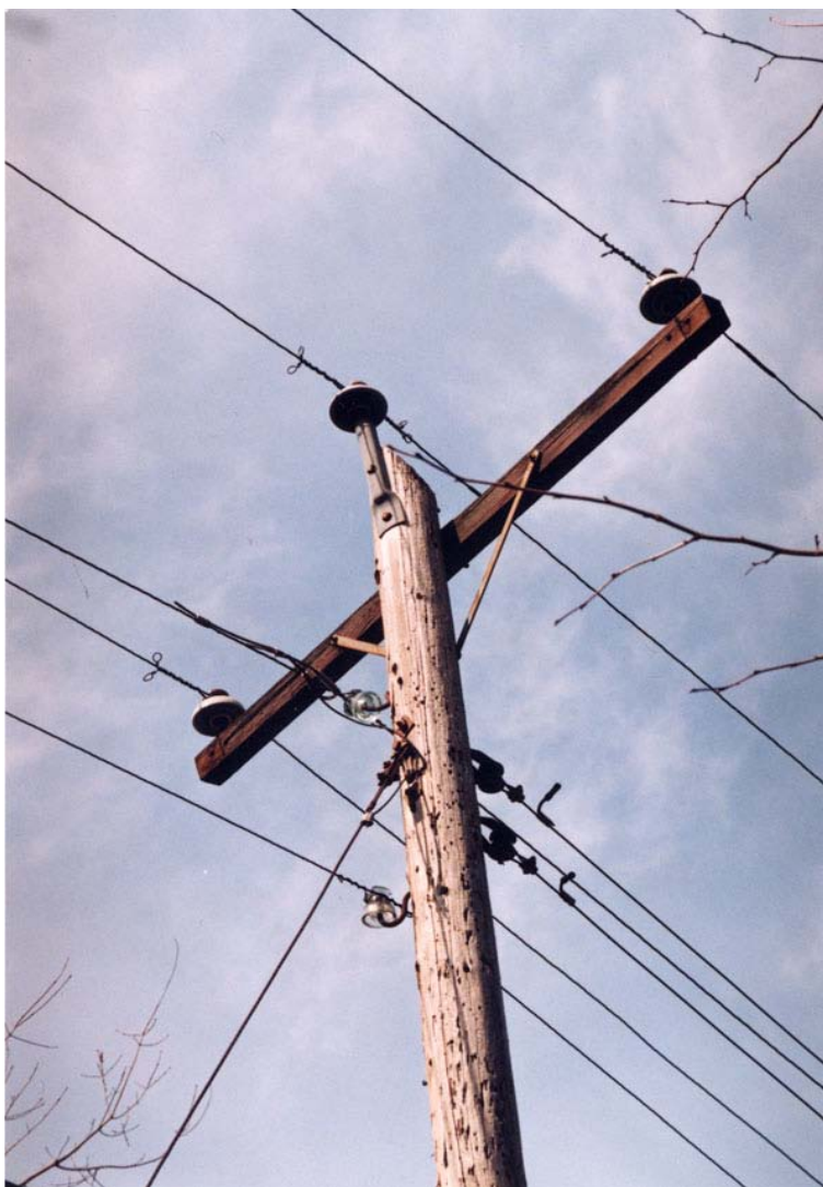
Poteau de distribution avant son démantèlement, 1996.
