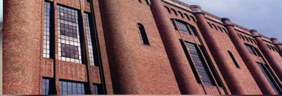
Centrale de Grand-Mère, mise en service en 1918
