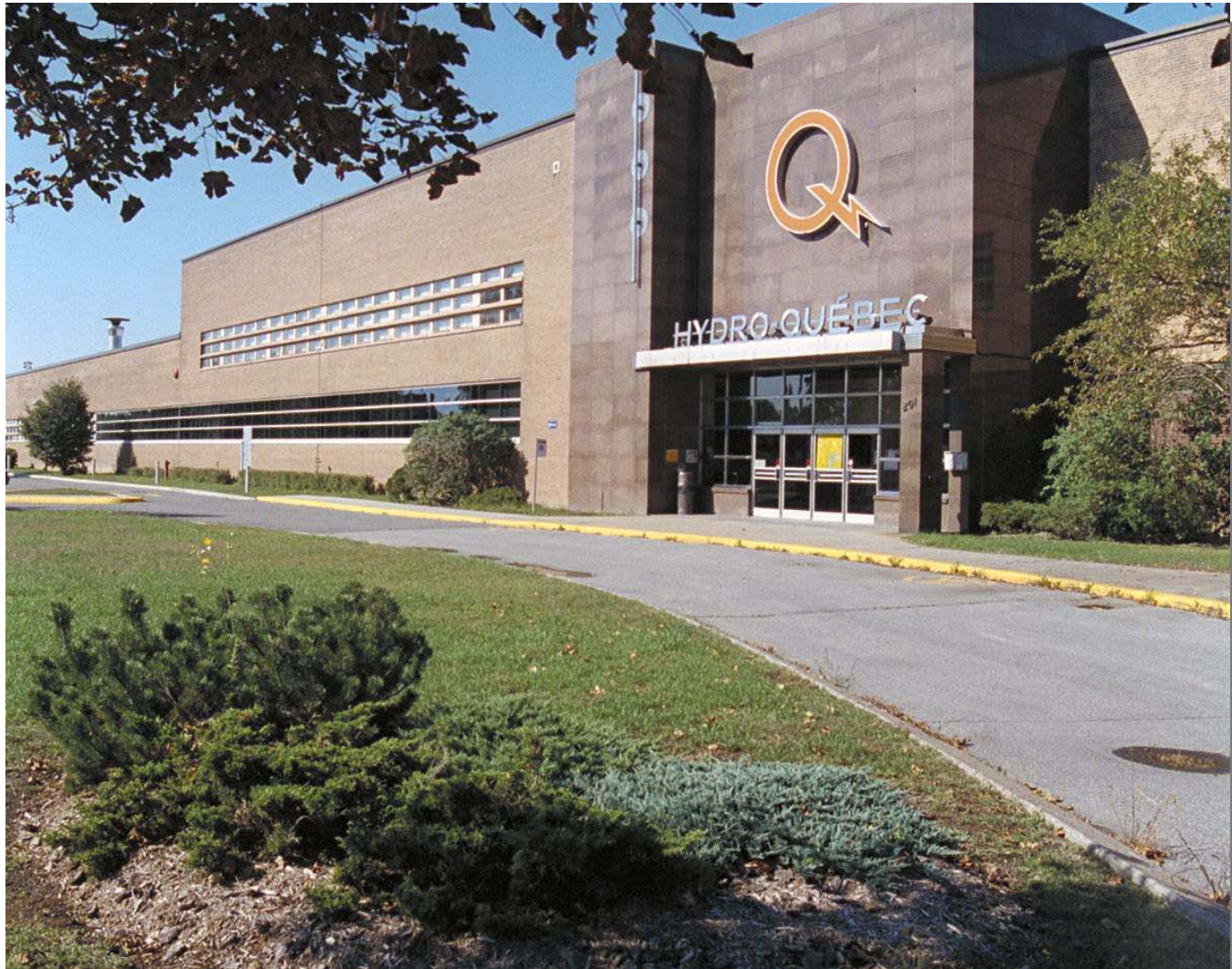
Centre de service Jarry, mis en service en 1952.
