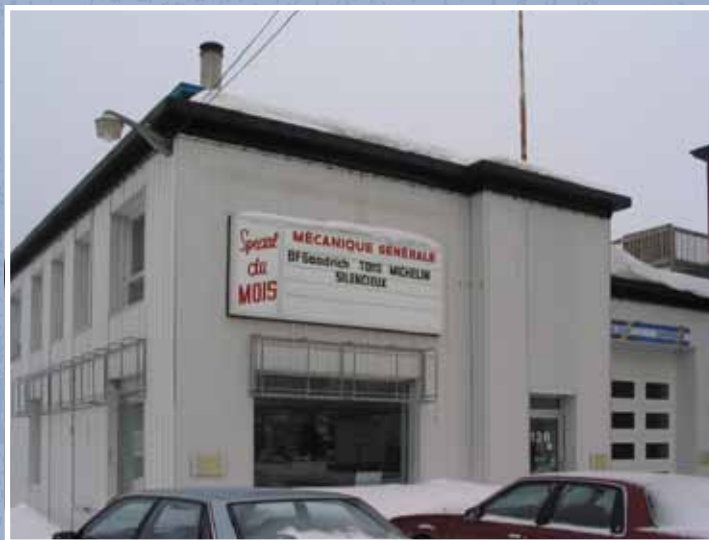
Avant et après : le 138, rue Saint-Germain Est à Rimouski.
