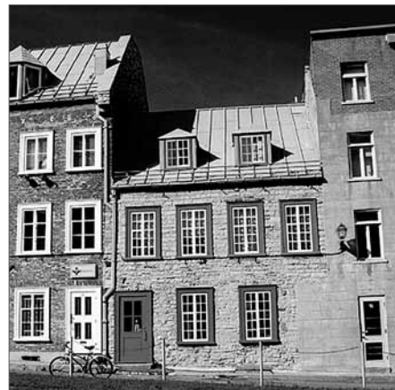
11, rue l'Ancien-Chantier (1670), bureaux de la filiale de la FHC la Fondation Rues principales, Québec (Qc)
