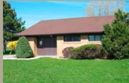
Sous-station maison Scarborough
