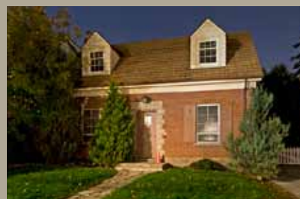
Sous-station 640, chemin Millwood
