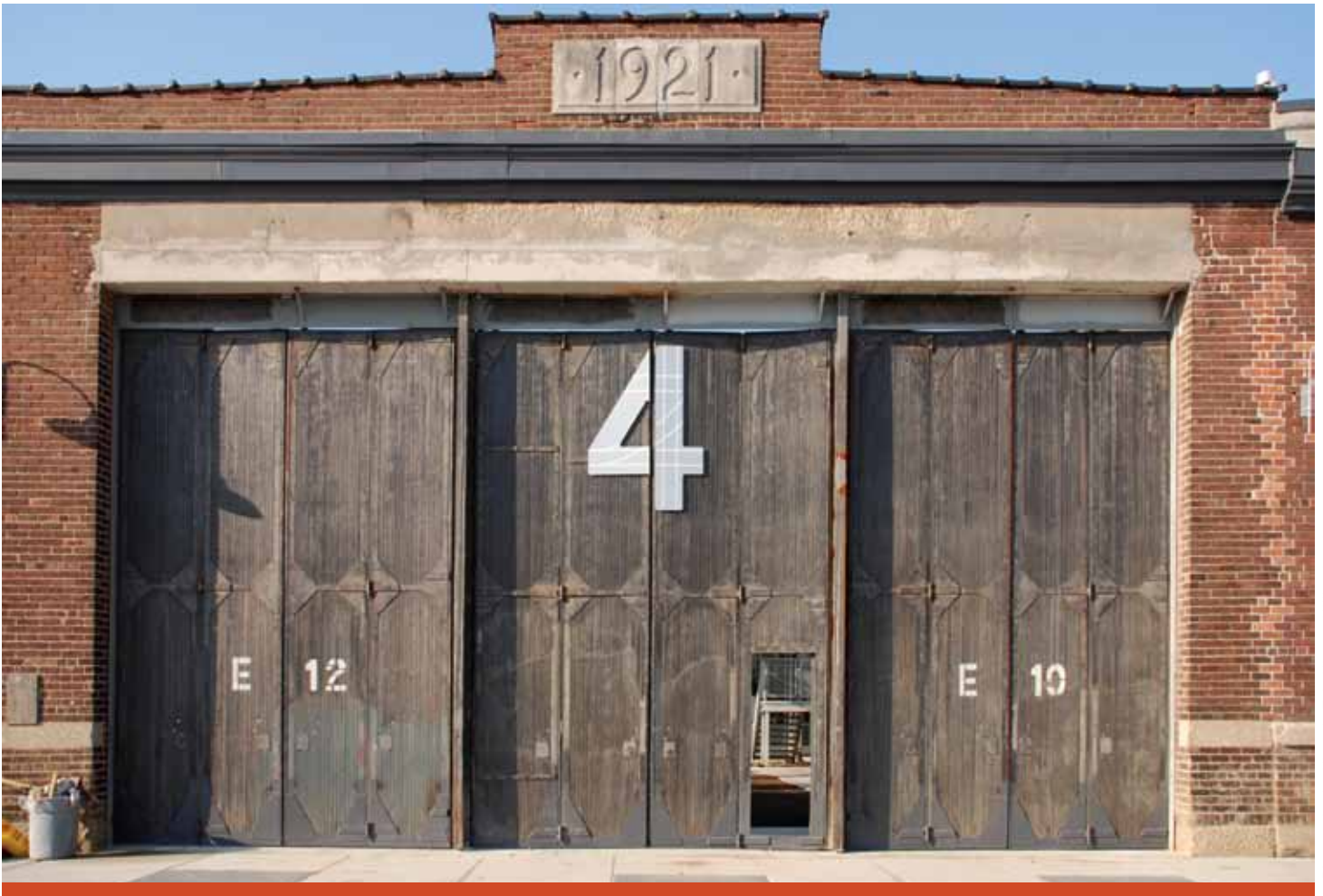
Photo : Ayako Kita, du Tott Allisopp Hillier Architects
