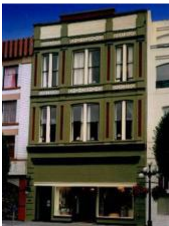
Le 1411, rue Government, après le restauration de la façade.
