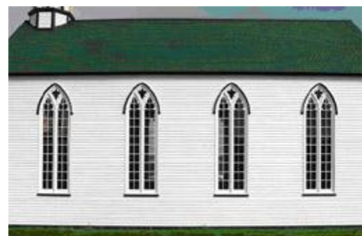
Des fenêtres restaurées de l'église catholique St. Joseph à Bonavista. Photo : Brian Ricks
