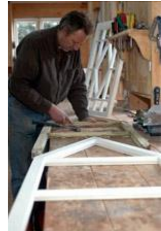
Mike Paterson en train de restaurer une fenêtre d'époque en bois. Photo : Brian Ricks
