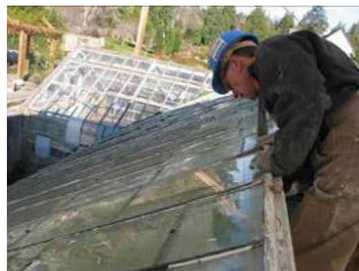
Davyd McMinn commence à retirer les carreaux de la section 4 de la serre.
