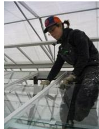
Hoff Boyle termine le vitrage de la section 5, côté sud.
