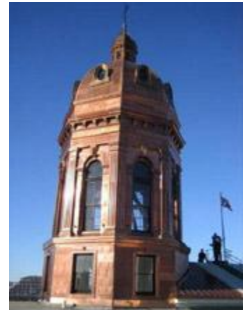
Restauration du dôme central, Édifice de l'Assemblée législative de Fredericton.
