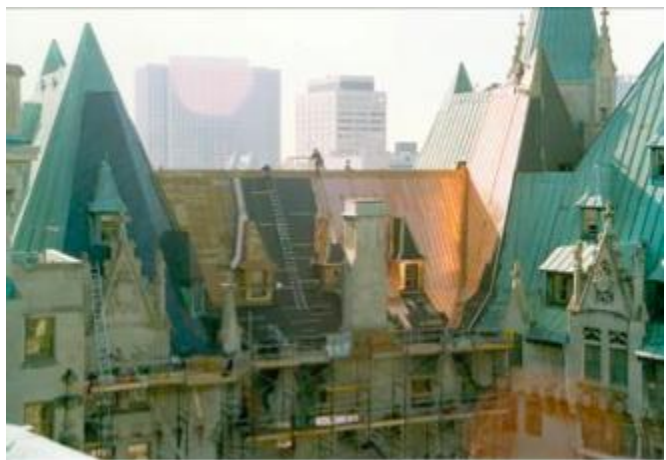
Restauration de la toiture du Château Laurier à Ottawa.
