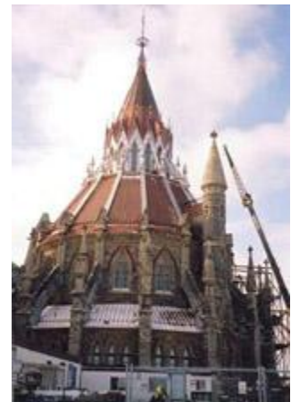
Restauration de la toiture de la Bibliothèque du Parlement à Ottawa.
